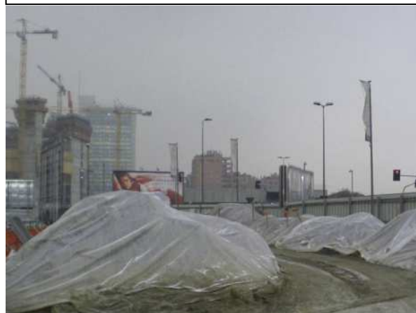
Protezione con teli delle terre di scavo
